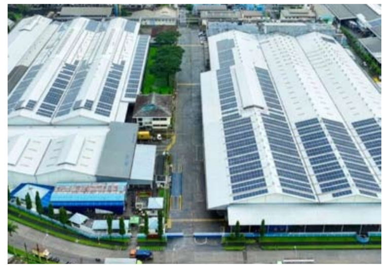
ABCPI工厂安装的屋顶太阳能发电装置。
